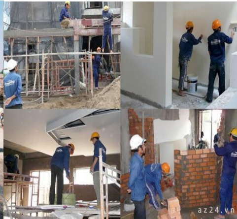
Công việc xây dựng
